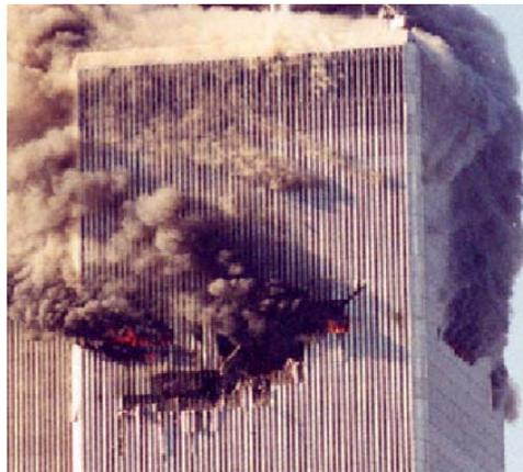
**Figure 4.** *Dégâts produits par l'impact du premier avion sur la tour Nord. Source NIST, Rapport 1-5A, 2005.*
